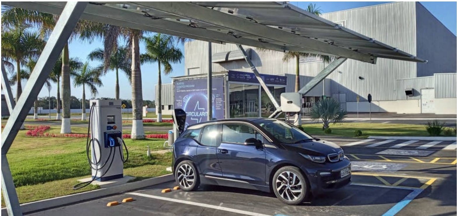
Carregador da Weg que opera com energia solar, em testes pela BMW Foto: Weg
